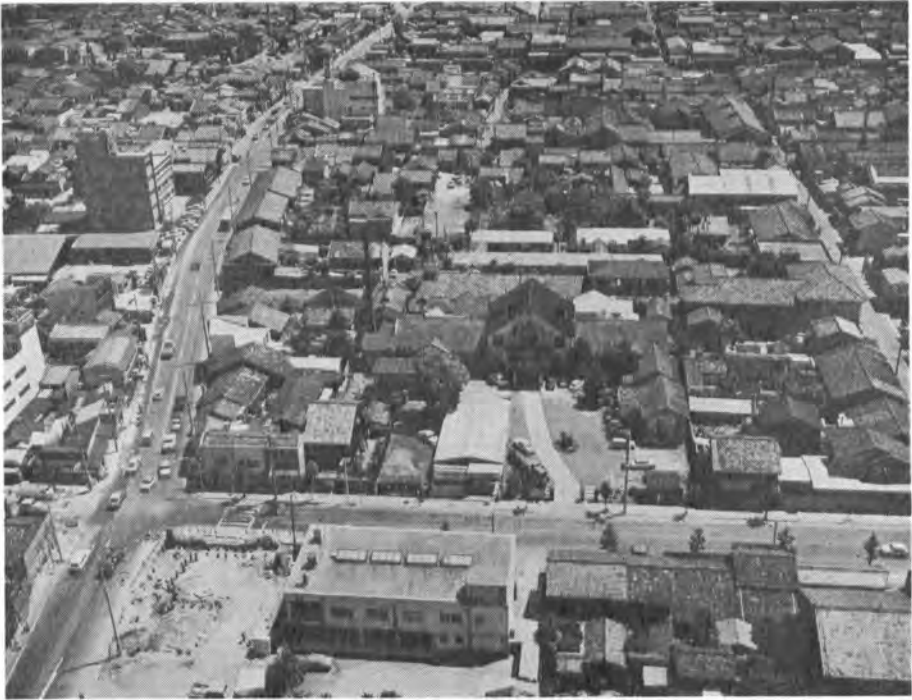
伏見分院北側上空から
