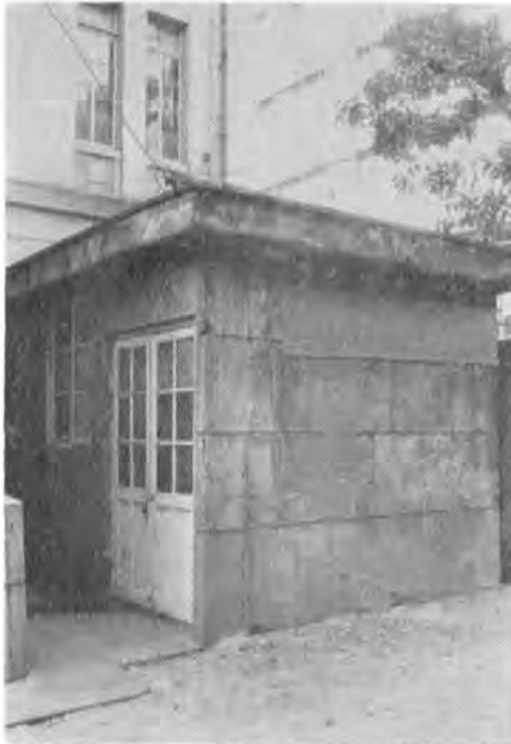
府職労組建物(現看護学院東北端にある)
