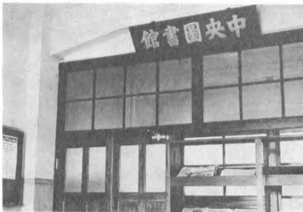
中央図書館 入口 (1972)
