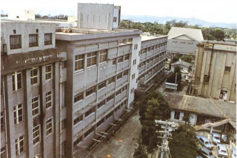
基礎二号館 (1972年)
