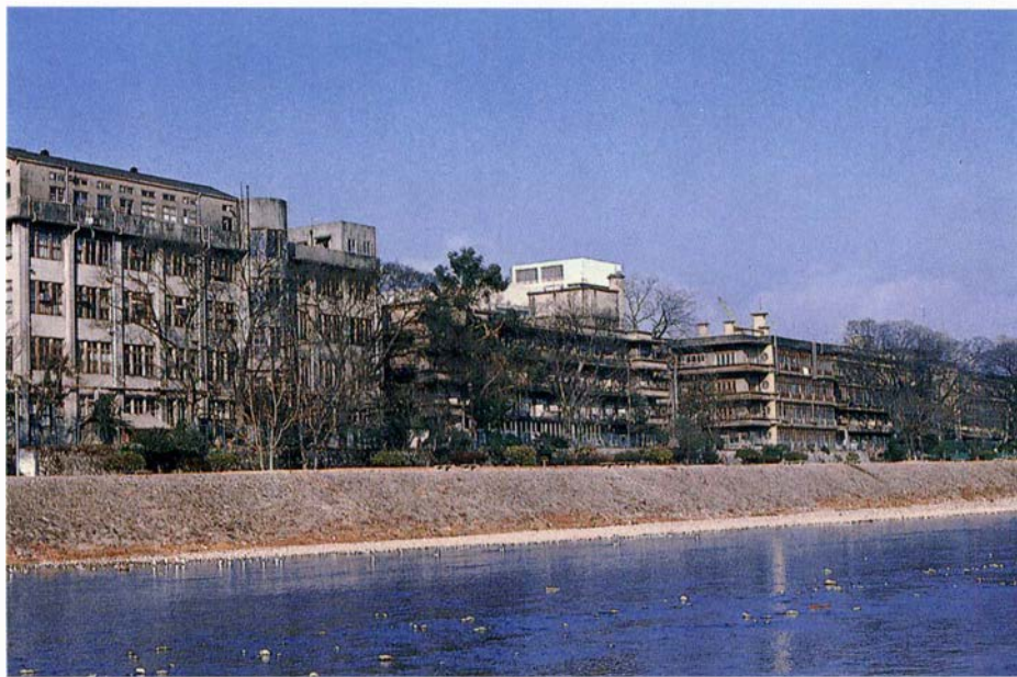
▼鴨川より基礎1号館及び病舎を望む（1982年）
