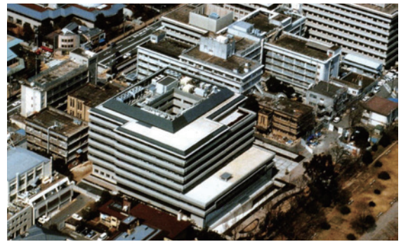
写真3 基礎1号館、基礎2号館、中庭の跡地に立つ基礎医学学舎
