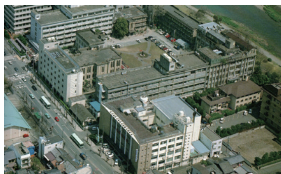
写真2 昭和末期の基礎1号館、基礎2号館の全景、中庭に療病院碑が建つ
