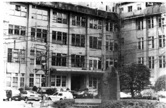
写真1 昭和50年代の大学中庭から見る基礎1号館
